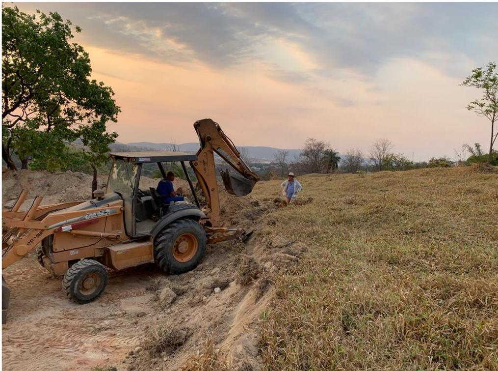
**Figura 5.9 – Construção de bacia de captação na propriedade do sr. Evaldo.**
