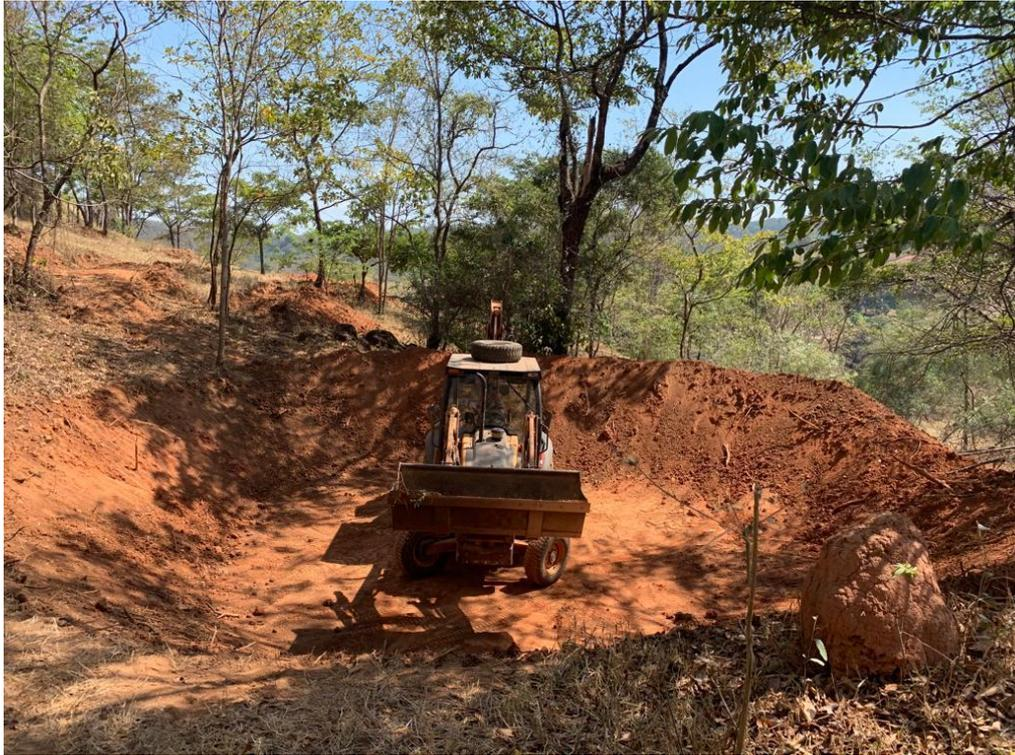
**Figura 5.4 – Construção de bacia de captação na propriedade do sr. Alberto.**
