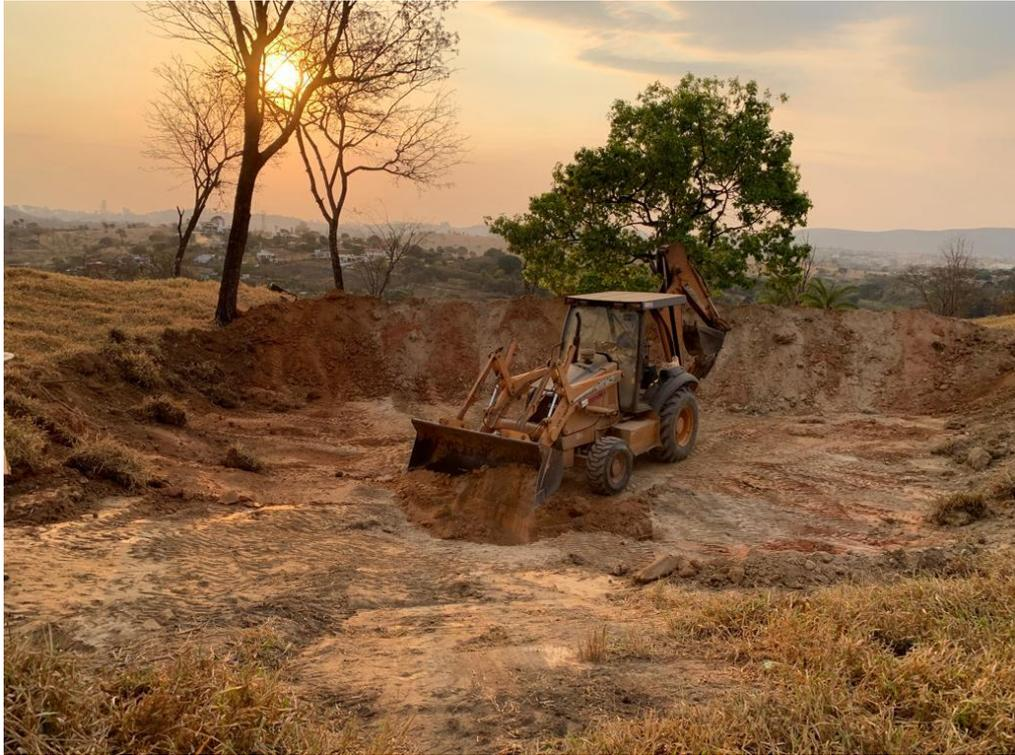
**Figura 5.2 – Construção de bacias de captação com retroescavadeira.**
