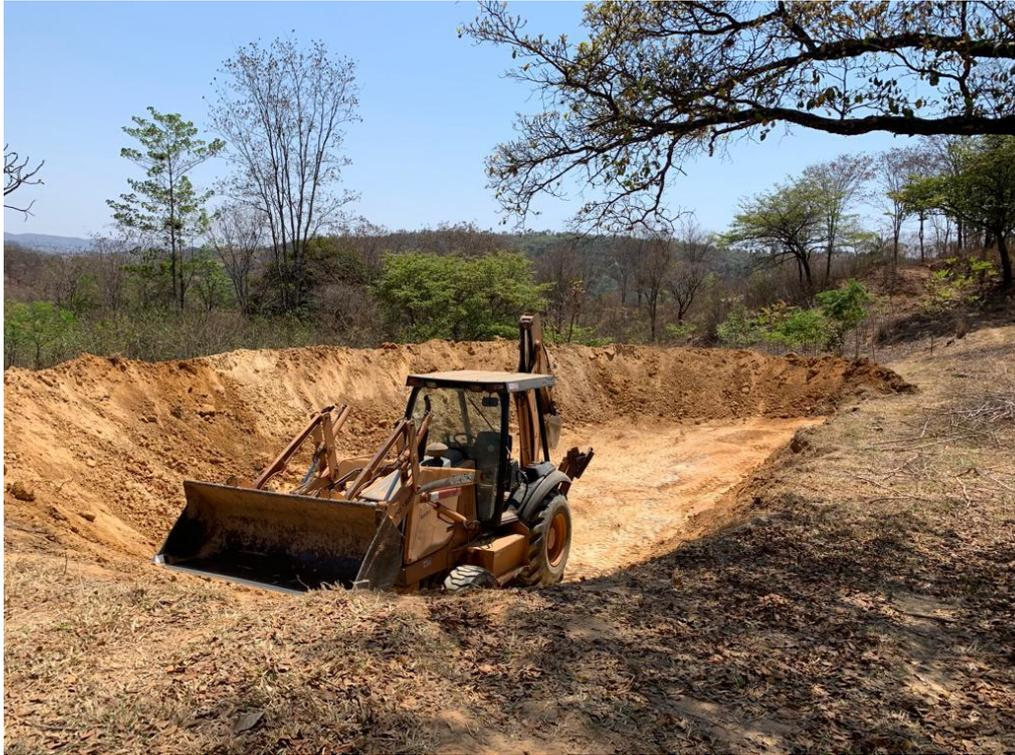
**Figura 5.8 – Construção de bacia de captação na propriedade do sr. Leonardo.**
