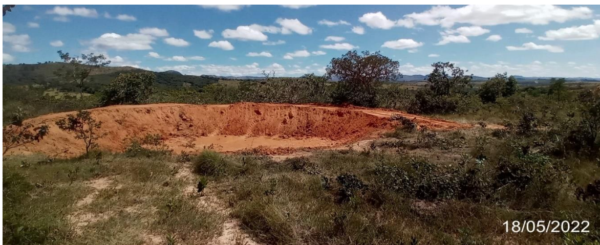
Figura 4.2 – Bacia de contenção
