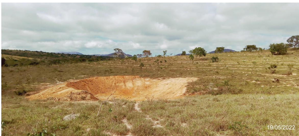
Figura 4.6 – Sulcos em contorno e bacia de contenção em perfeitas condições
