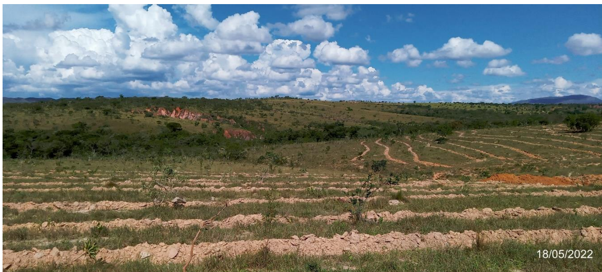
Figura 4.3 – Sulcos em contorno em perfeitas condições
