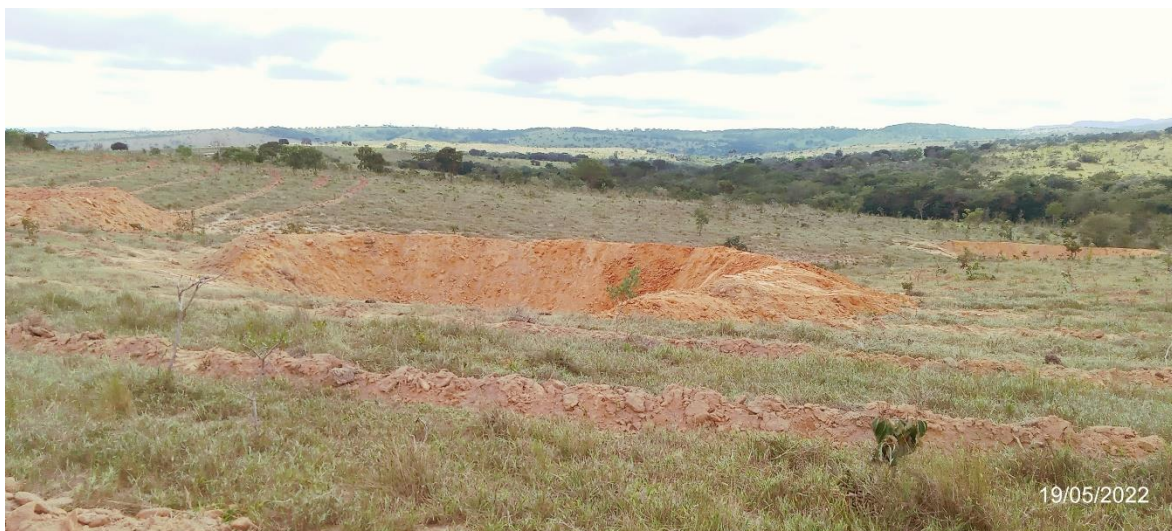
Figura 4.5 – Sulcos em contorno e bacia de contenção em perfeitas condições
