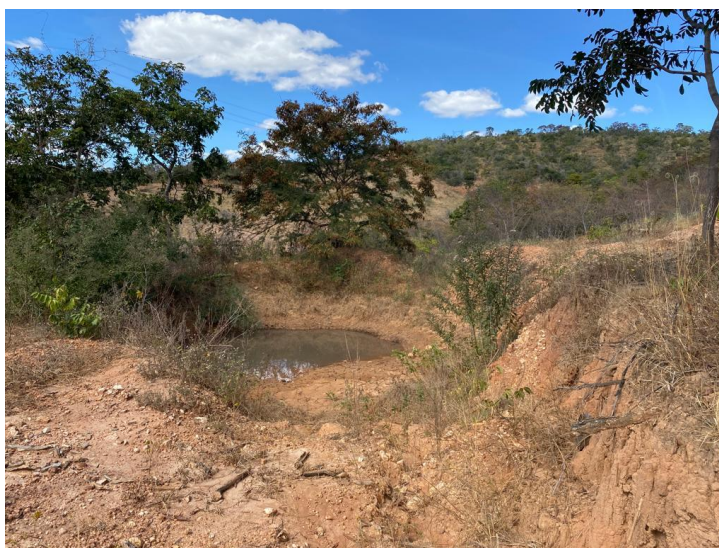
Figura 4.2 – Inspeção de barragem executada na microbacia do Córrego dos Cocos
