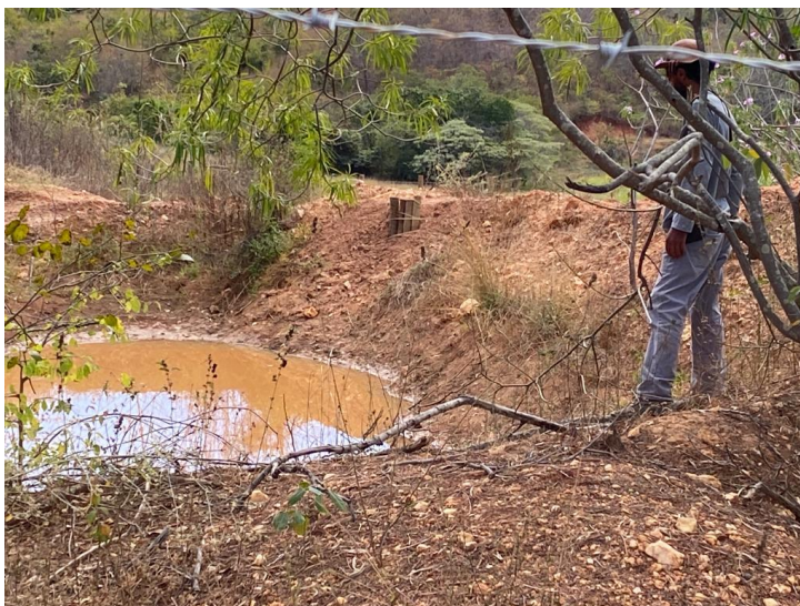
Figura 4.3 – Inspeção de barragem executada na microbacia do Córrego dos Cocos Fonte: FORTAL ENGENHARIA (2023)
