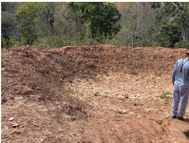
Figura 4.4 – Inspeção de barragem executada na microbacia do Córrego dos Cocos Fonte: FORTAL ENGENHARIA (2023)
